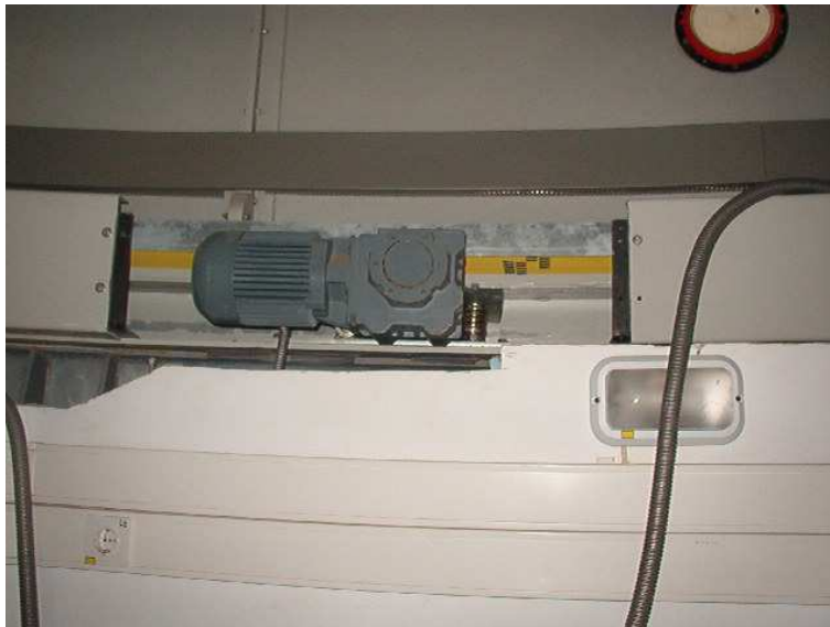
Abbildung 5.2: Eine der Motoreinheiten des Kuppelantriebes am Skinakas Observatorium
