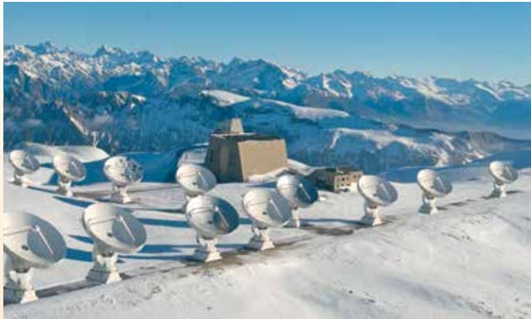
Viele der Moleküle in Sternentstehungsregionen strahlen im Radiobereich. Nach seiner Fertigstellung wird NOEMA aus zwölf 15-Meter Radioantennen bestehen (wie hier in dieser Fotomontage gezeigt). MPE-Astronomen nutzen diesen Teleskopverbund zusammen mit anderen Beobachtungsstationen wie ALMA, um insbesondere das kalte Gas in Galaxien zu untersuchen.
